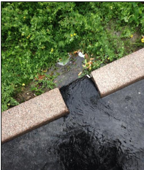
Figur 11 Utformning av kantsten för tillrinning av dagvatten till växtbädd.
