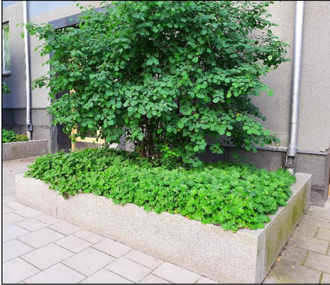
Figur 10 Exempel på upphöjd växtbädd kopplad till tak via stuprör.
